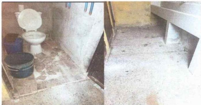
Foto 5: Mantenimiento y sustitución de piso de torta a cerámico. Modulo baño.
