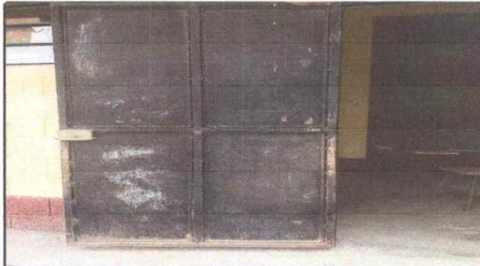
Foto 2: Mantenimiento de puertas, lijado, cepillado y aplicación de pintura. Modulos 1,2,3,4 y 5.
