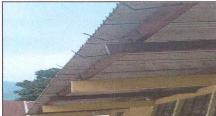
Foto 3: Sustitución de canal de metal. Modulos 1,2,3,4 y 5.
